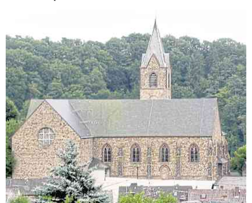
Die Sanierungsarbeiten von St. Matthias in Ulmen sind weitgehend abgeschlossen, nun geht es im Inneren weiter. Foto: Wilfried Puth
